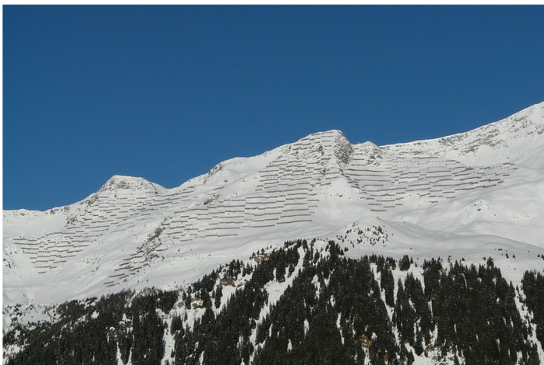
Ripari valangari sopra Airolo
